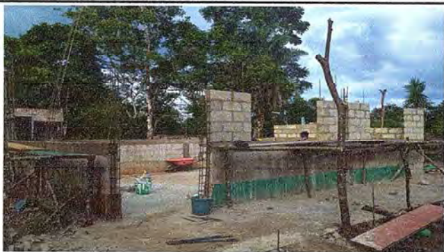
Foto1: Se inicia los trabajos de remozamiento de la escuela.
