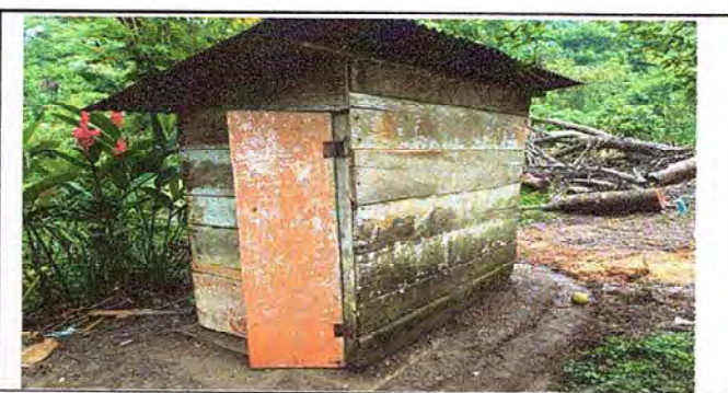
Foto 6: Cambio de puerta de los baños.
