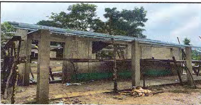
Foto 5: Colocación de estructura y bases para las paredes y techo de la escuela.
