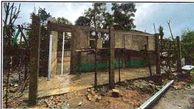
Foto 2: Construcción de columnas de concreto.
