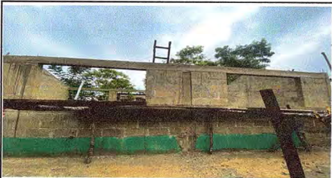
Foto 3: Avance en la construcción de ventanas parte frontal y trasera.
